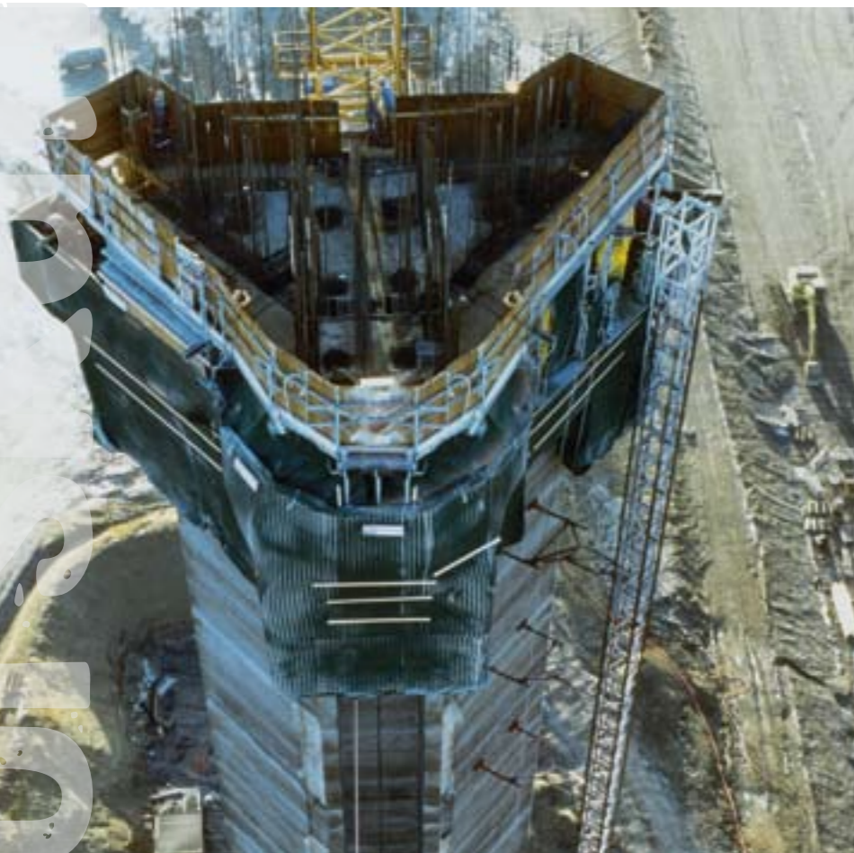
Kontrolltårn OSL - Gardermoen Høyde 87 meter med varierende tverrsnitt.
